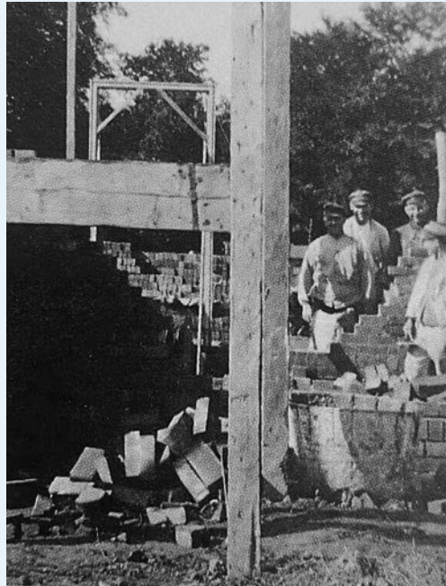
Die Gartenstadt Berne entsteht: Handwerker beim Bau eines Hauses, 1920er Jahre
